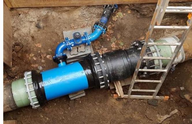
**Passstück:** Platzhalter setzen und Verbindung der Linderenden zum Anschlussstück
