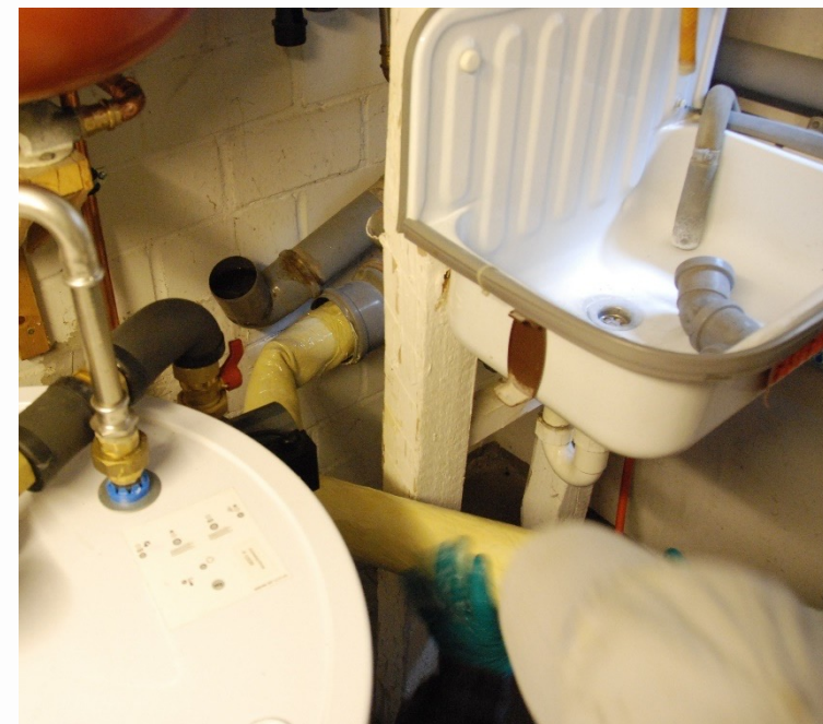
Einbringen eines Kurzliners in die Rohrleitung im Gebäude
