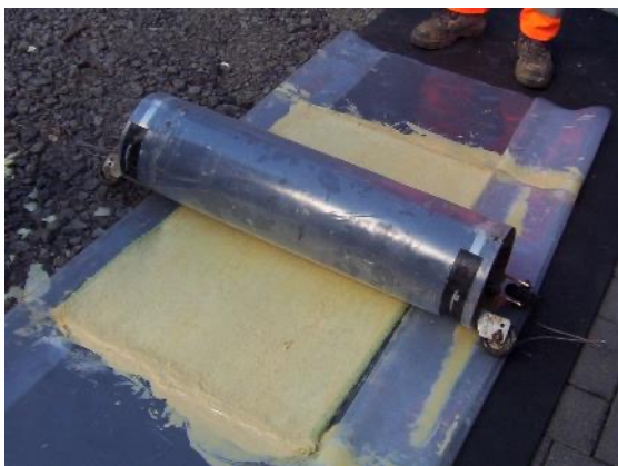
Wickeln der getränkten Glasmatte um den Packer
