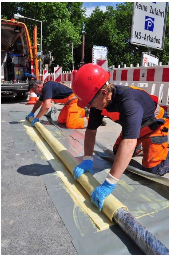
Wickeln der getränkten Glasmatte um den Packer
