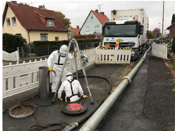
Bild 15: Blechmanschetten einsetzen
