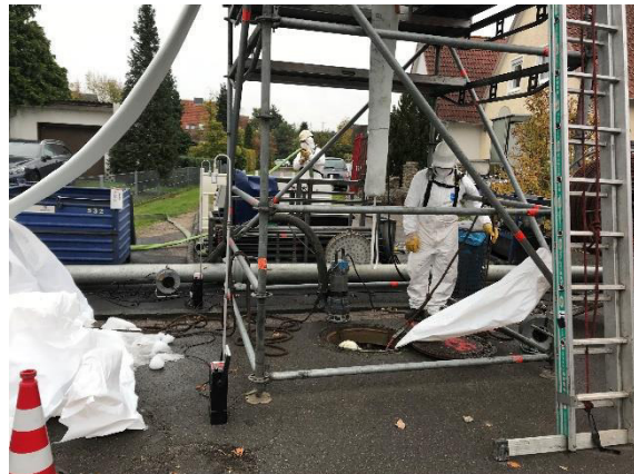
Bild 18: Inversionsturm mit eingebautem Preliner Bild 19: Vorbereitung Schlauchliner invertieren
