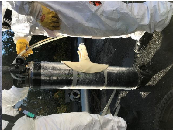
Bild 20: Packer für Hutprofilmontage
