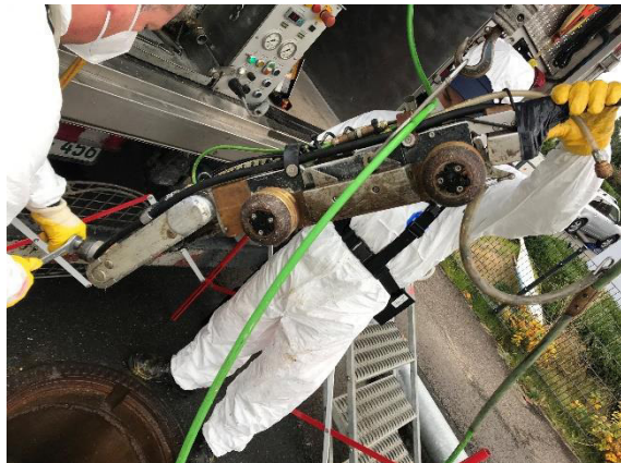
Bild 6: Werkzeug/Aufsatzwechsel Schwalm Roboter
