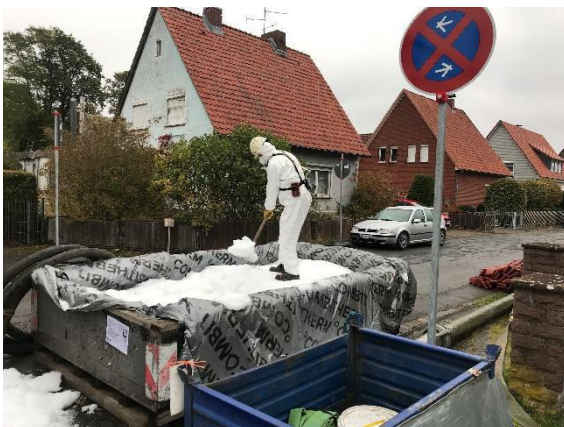
Bild 16: Eis vom Schlauchliner entfernen
