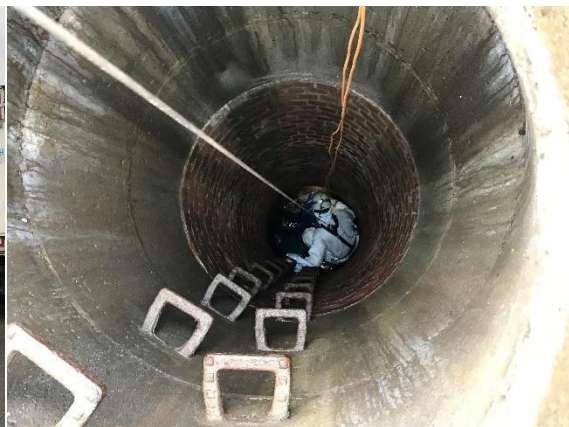
Bild 20: Schlauchliner Einbau durch Inversion Bild 21: Schlauchliner ansetzen
