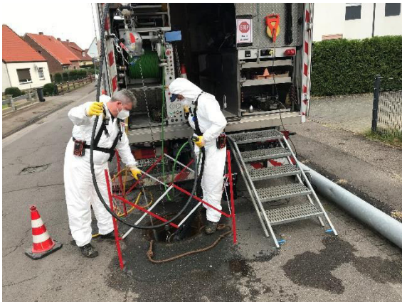
Bild 5: Reinigung des Roboters über Schacht
