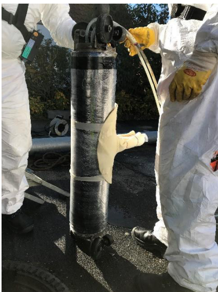
Bild 31: Hutprofil einbauen
