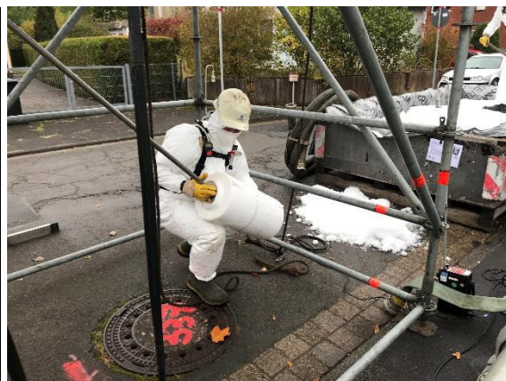
Bild 17: Preliner vorbereiten
