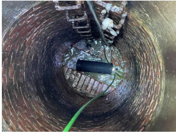
Bild 34: Absperrblase einsetzen mit Roboter
