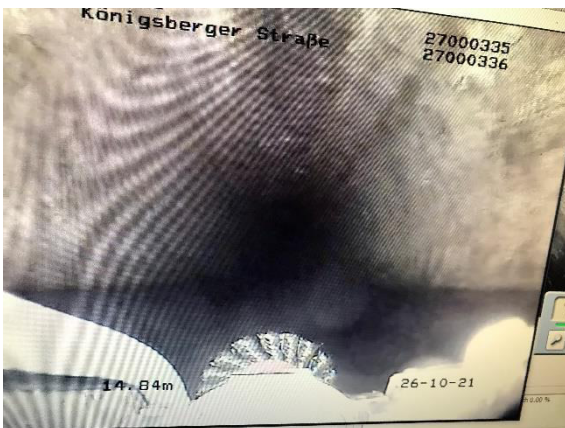
Bild 9: Ablagerungen entfernen (Bürstenaufsatz)
