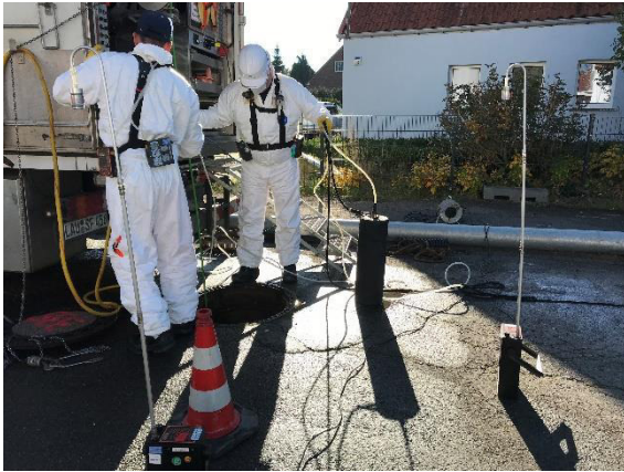
Bild 33: Absperrblase setzen
