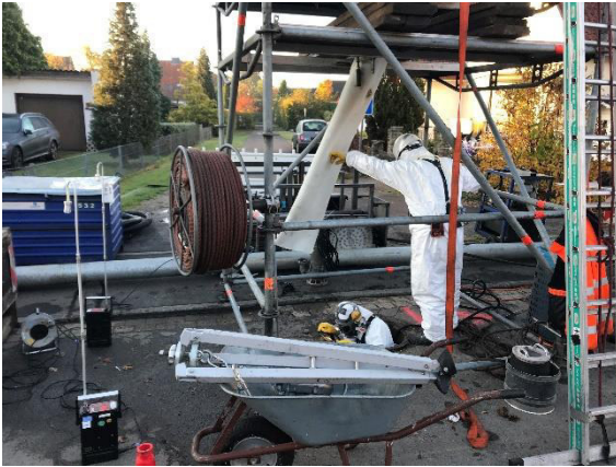
Bild 13: Inversionsturm, Seilrolle, Dreibein
