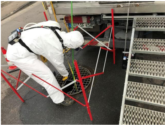
Bild 7: Einmessen der Zugänge
