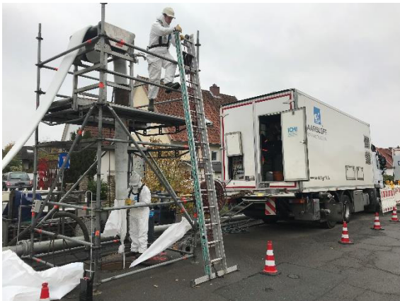
Bild 18: Inversionsturm mit eingebautem Preliner Bild 19: Vorbereitung Schlauchliner invertieren
