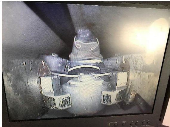
Bild 36: Packer einsetzen um Hutprofil zu setzen
