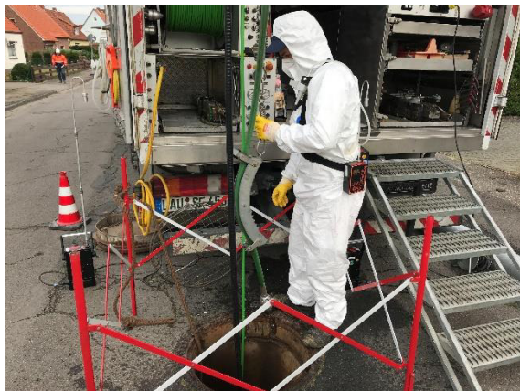
Bild 4: Kanalspülen (Zwischenspülung)
