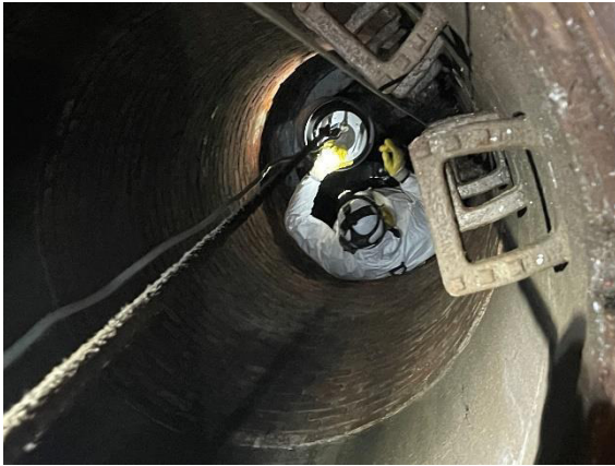
Bild 24: Absperrblase setzen Flex
