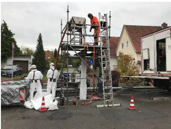
Bild 20: Schlauchliner Einbau durch Inversion Bild 21: Schlauchliner ansetzen
