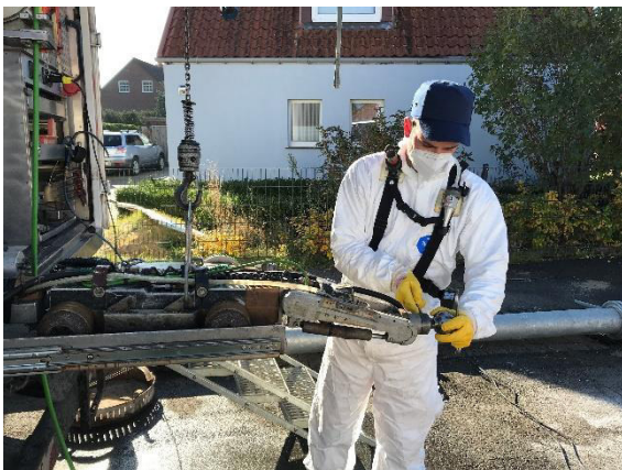
Bild 29: Fräskopfwechsel an Roboter
