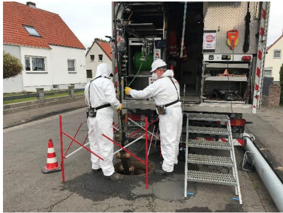
Bild 2: Schwalm Roboter in Schacht ablassen
