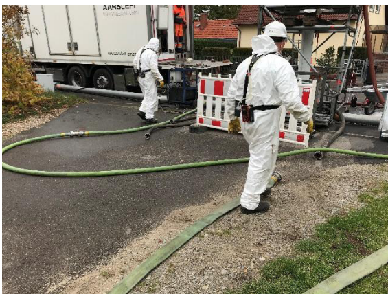
Bild 22: Installation Ringleitung (Warmwasser) Bild 23: Absperrblase setzen
