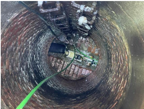
Bild 35: Absperrblase einsetzen mit Roboter
