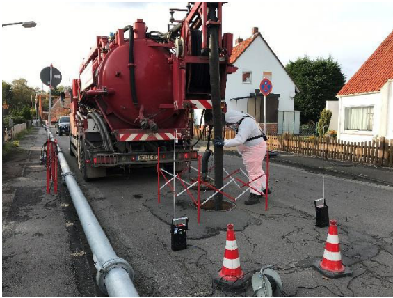
Bild 1: Vorbereitungsarbeiten, Kanalspülen, Remondis
