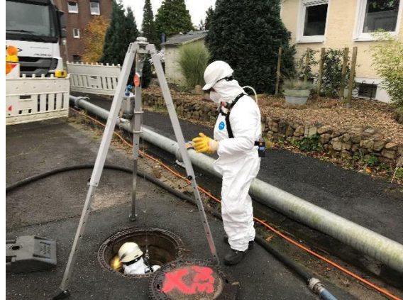
Bild 13: Einsetzen der Frässhutzmanschetten
