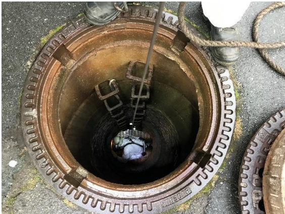
Bild 14: Arbeiten im Schacht
