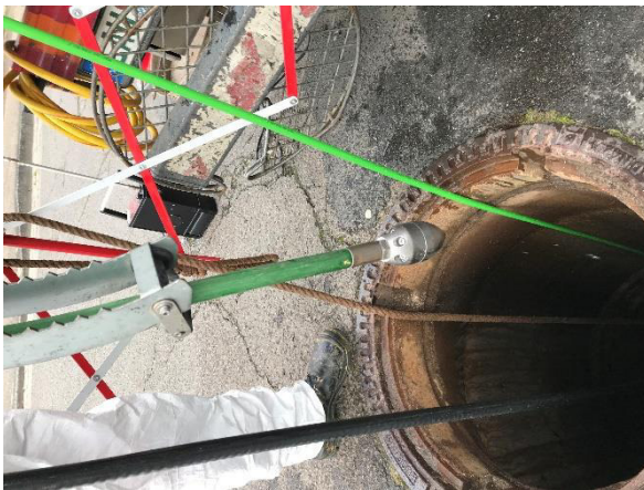
Bild 3: Spüldüse (ca. 100 bar Wasserdruck)
