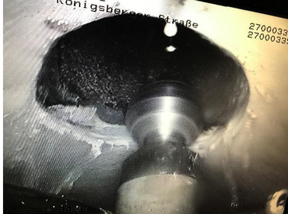
Bild 28: Öffnen der Zuläufe mit Fräsaufsatz mit Schwalm Roboter
