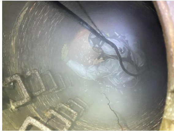
Bild 25: Schlauchliner aufschneiden mit DL-Säge/ „Schlauchlinerkopf öffnen“, Wasser im Schacht
