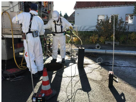
Bild 30: Absperrblase setzen (mit Roboter)
