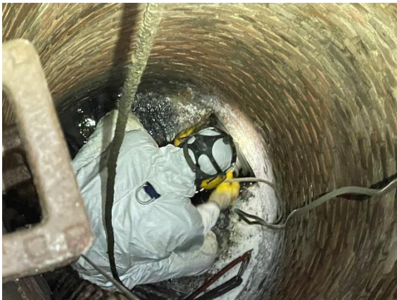
Bild 26: Schlauchliner aufschneiden mit DL-Säge/-Flex
