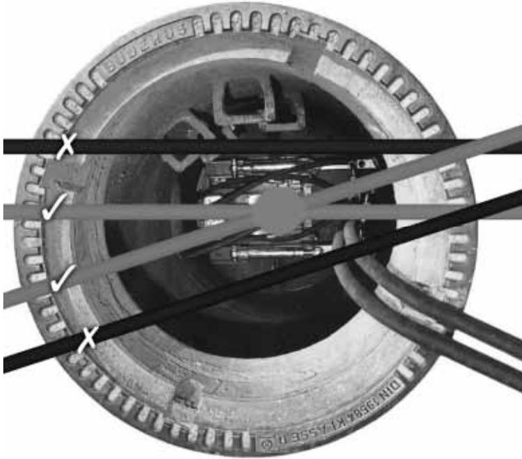
**Abbildung 11: Lage Zu und Ablauf im Rohreinbauschacht**
