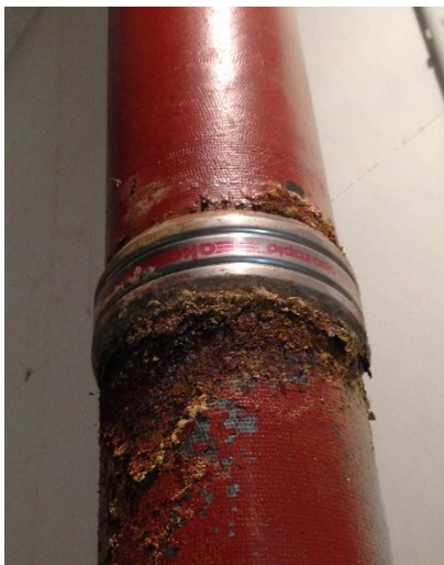
Abbildung 6: undichte Manschettenverbindung
