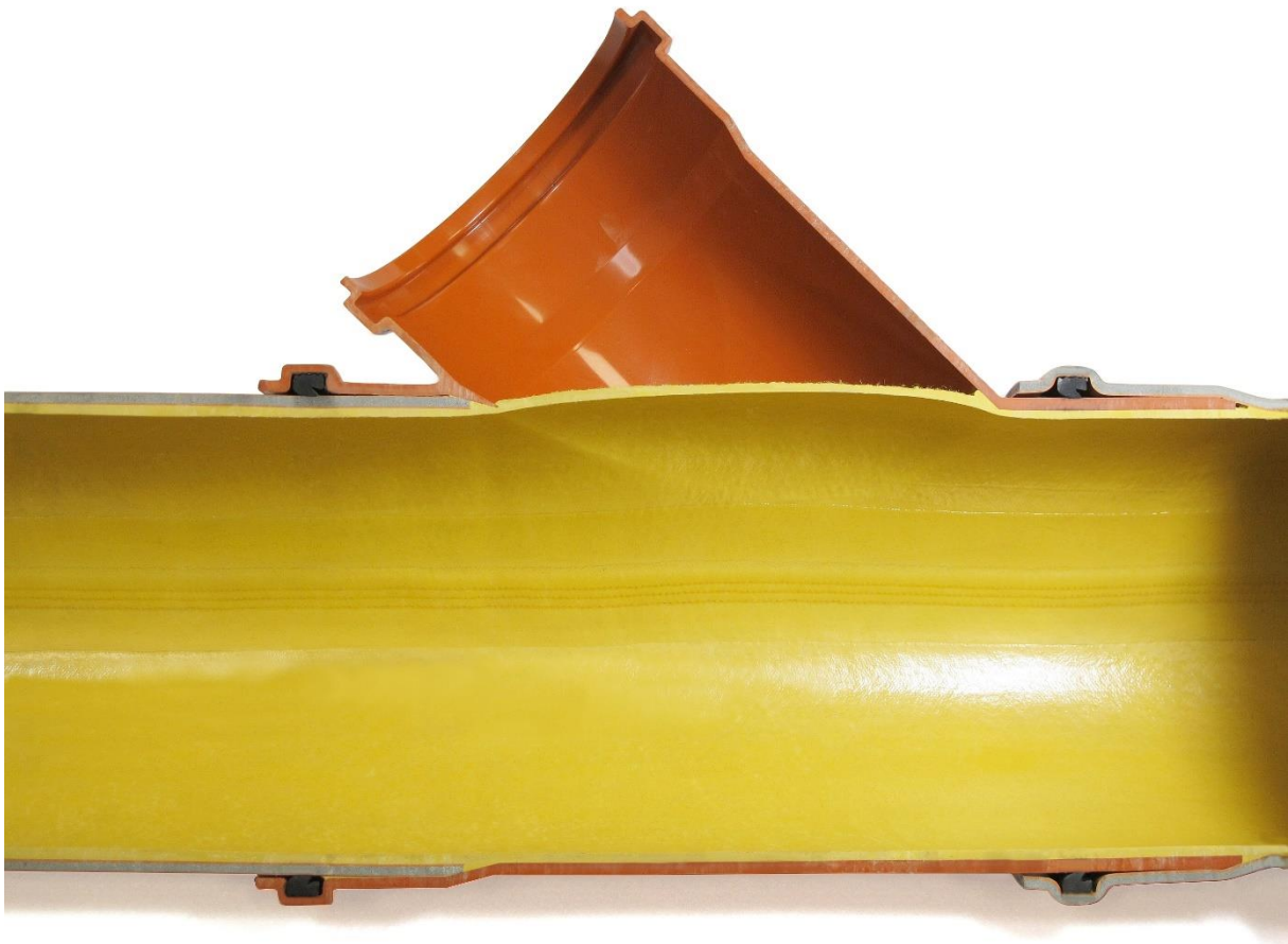
Abbildung 2: ausgehärteter Schlauchliner im PVC-Rohr
