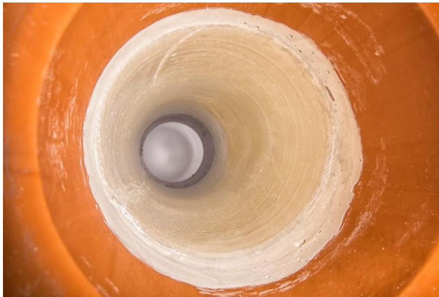
Abbildung 5: Kurzliner in PVC-Rohr eingebaut
