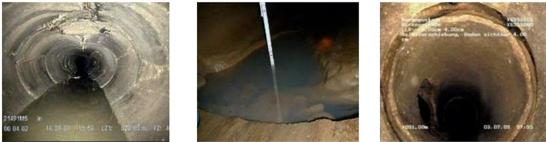
Abbildung 5: Anwendungsbeispiele für das TIP-Verfahren. Links: Deformation (AZ IIIa), Mitte: Ausbruch an der Rohrsohle (AZ III), Rechts: fehlendes Rohrstück (AZ IIIa)
