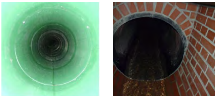
Abbildung 6: Links: Mit dem TIP-Verfahren saniertes Rohr. Rechts: Schachtanbindung
