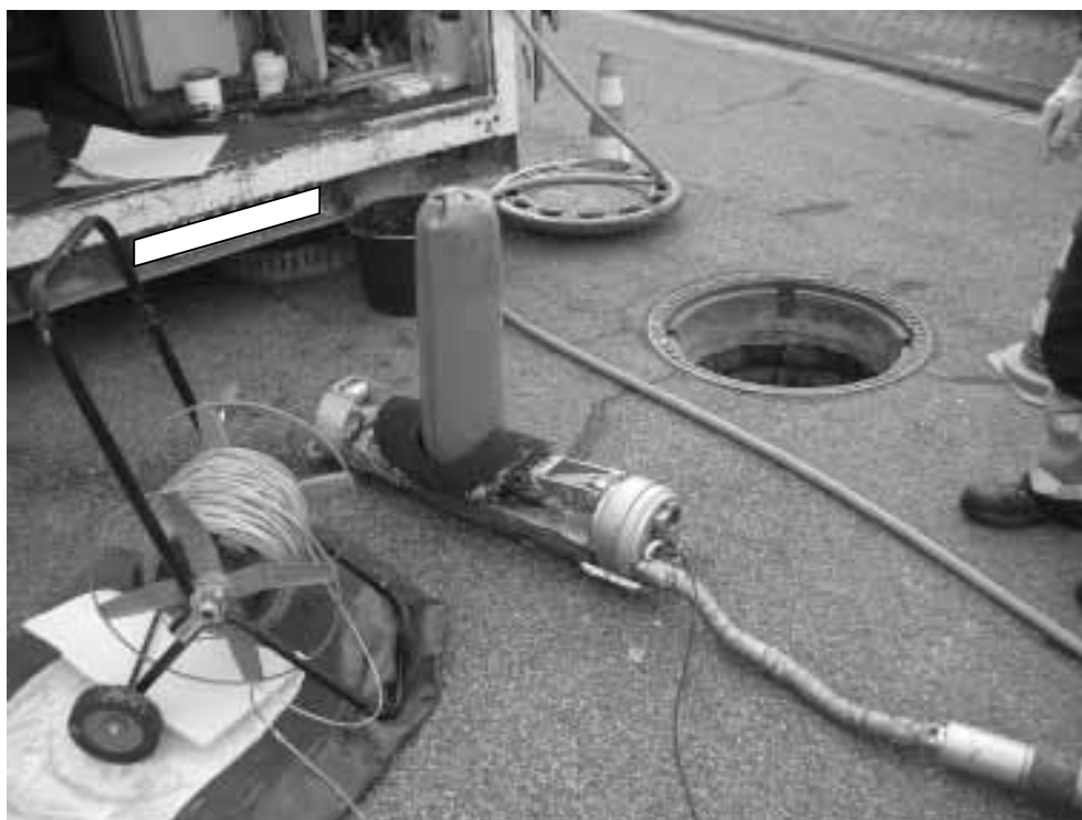
Bild 1: Hutprofilsetzgerät mit ausgefahrenen Stützen (Funktionsprüfung)
