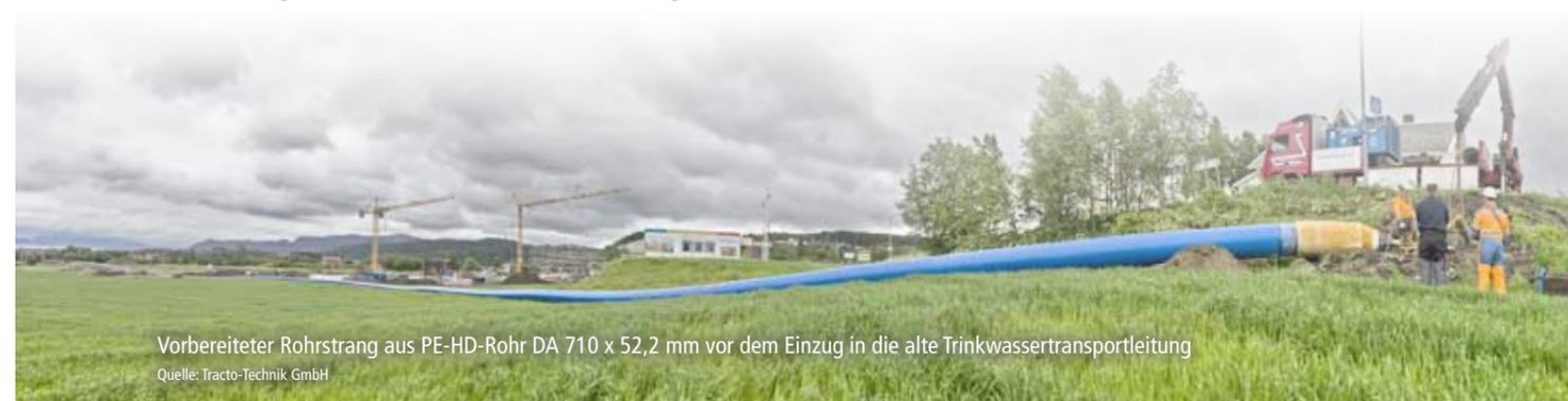
Vorbereiteter Rohrstrang aus PE-HD-Rohr DA 710 x 52,2 mm vor dem Einzug in die alte Trinkwassertransportleitung
