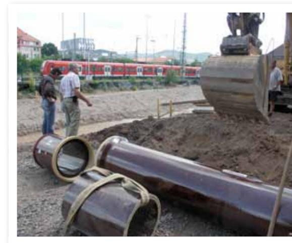
Bau eines Mischwasserkanals mit Steinzeugrohren der Nennweite DN 300 bis DN 500
