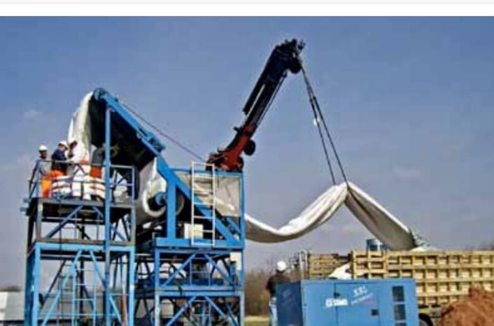
Inversion eines Schlauchliners über ein Gerüst
