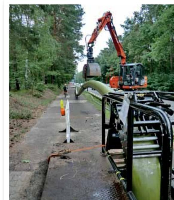
Sanierung einer Abwasserleitung mit Hilfe des TIP-Verfahrens
