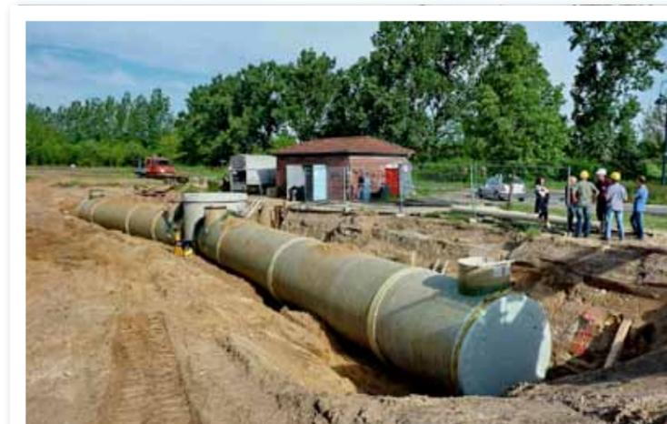
Neuer Stauraumkanal aus GFK-Wickelrohr DN 2400
