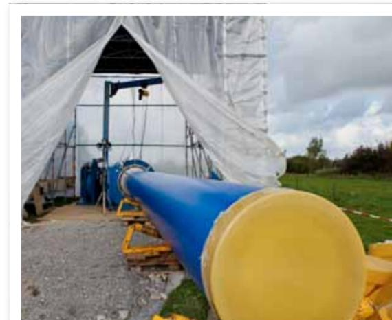
Beim Rohrstrangrelining (hier PE-HD) werden die Rohre vor der Einbaustelle zu einem Strang zusammenschweißst und dann komplett eingezogen
