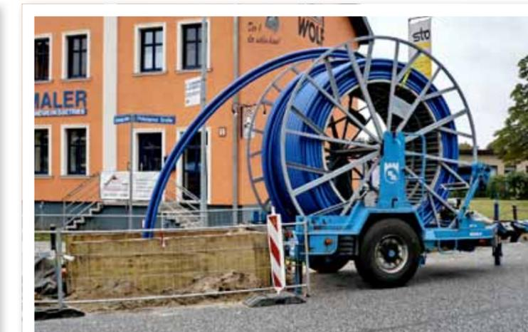
Close fit-Sanierung mittels vorverformten PE-Rohr –
