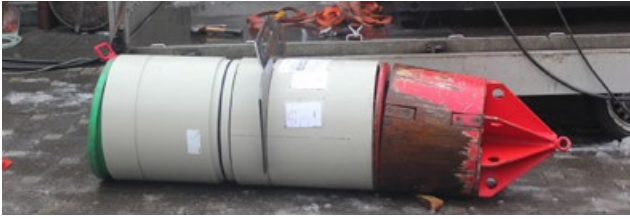
Abb. 3 – Mit einer hydraulischen Schubvorrichtung wird die Kaliberhülse in das Altrohr geschoben. Anschließend folgen die Kurzrohre.
