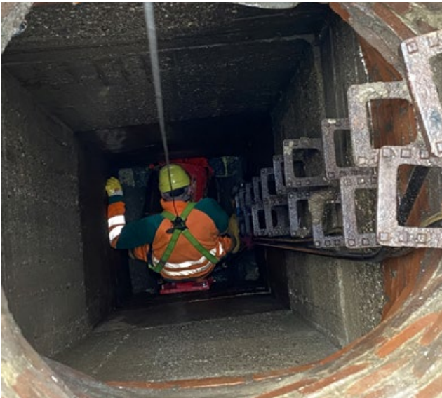
Abb. 4 – Einsatz der Schubvorrichtung im Kanal.
